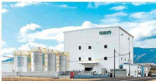
1月下旬に稼働を始めた大野鷲工場。揖斐郡大野町公郷
