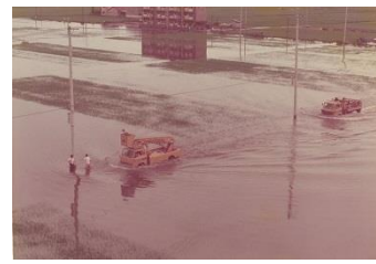
沈んだ町を駆ける工事車両
